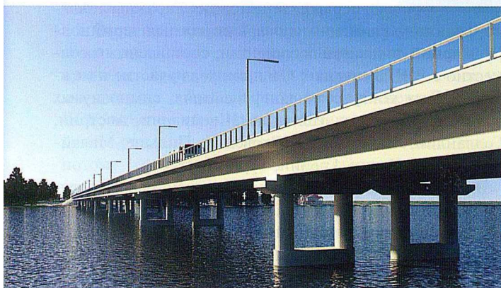
Белгородский мост через Белгородское водохранилище
